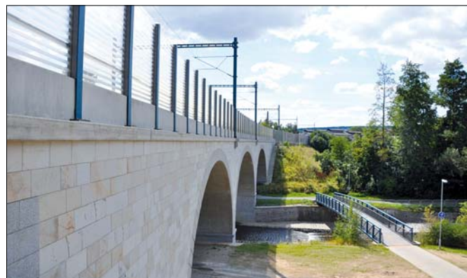
Běžně používaná varianta prosklených hlukových stěn zachovává estetický komfort a výhled a nenarušuje negativně krajinný ráz. Ilustrační foto
