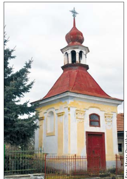
V Hroněticích čeká na opravu kaplička se zvoničkou z roku 1802 zasvěcená svatému Vojtěchovi.
