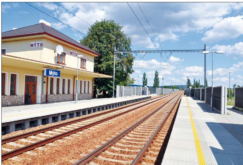
Příklad použití protihlukových stěn. Ilustrační foto
